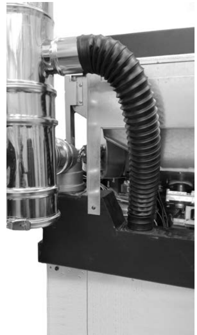
Fig. 84 - Raccordement du raccord de l'air
