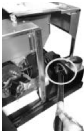
Fig. 120 - Nettoyage du conduit d'évacuation des fumées
