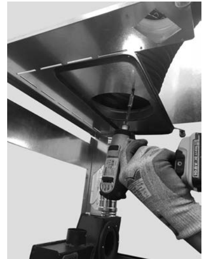
Fig. 72 - Fixation du tuyau flexible
