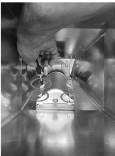
Fig. 95 - Retrait des vis
