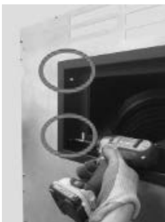
Fig. 73 - Fixation externe de la trappe
