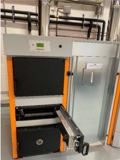
L'ouverture de la porte d'allumage ou de la porte de chargement démarre automatiquement la « phase d'allumage » (statut : 2) et démarre le ventilateur des fumées.
