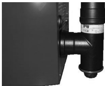
Fig. 73 - Nettoyage du conduit de fumée
