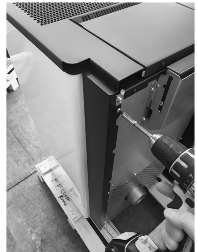
Fig. 46 - Fixer le flanc complet
