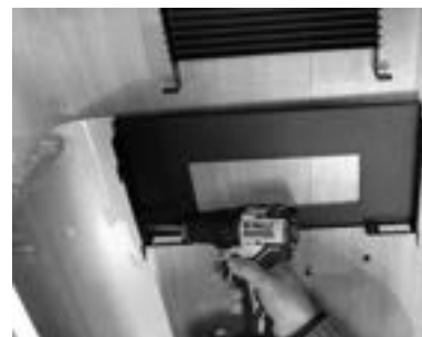
Fig. 29 - Fixer le panneau au montant
