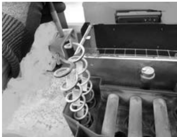
Fig. 94 - Remplacement des turbulateurs si nécessaire
