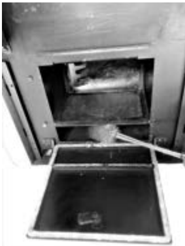
Fig. 81 - Nettoyer avec un goupillon.
