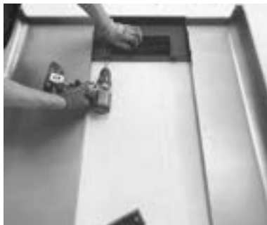
Fig. 39 - Fixation de la grille
