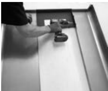
Fig. 38 - Fixation de montant
