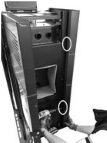
Fig. 49 - Fixation avant du panneau latéral
