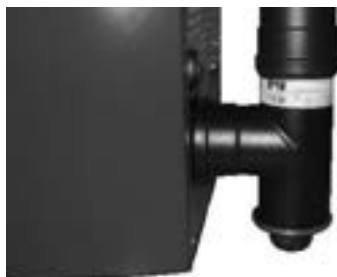
Fig. 76 - Nettoyage du conduit de fumée
