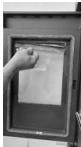
Fig. 53 - Retirer le profil
