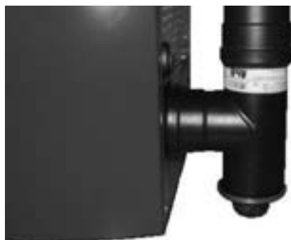
Fig. 54 - Nettoyage du conduit de fumée
