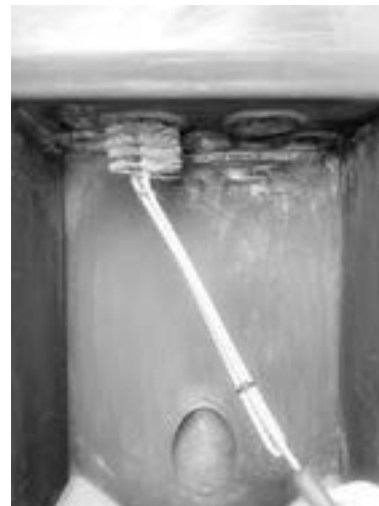
Fig. 61 - Nettoyer avec un goupillon.
