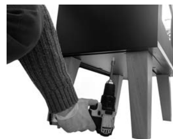
Fig. 27 - Fixation du poêle
