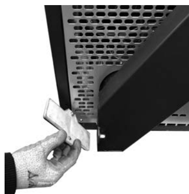
Fig. 73 - Nettoyage du conduit de fumée
