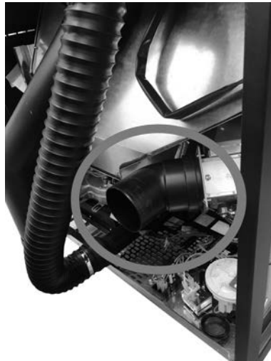
Fig. 44 - Placer le raccord à 45°
