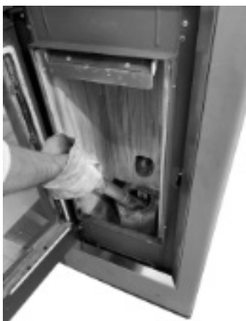
Fig. 33 - Nettoyage l'espace du brasero
