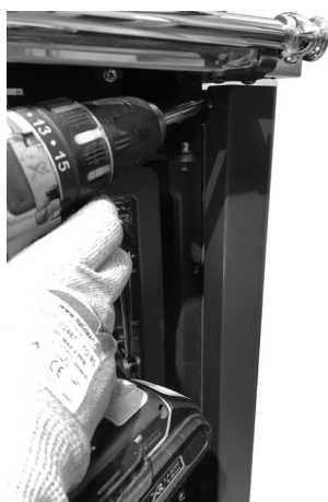
Fig. 39 - Accrocher les parois sur 2 vis
