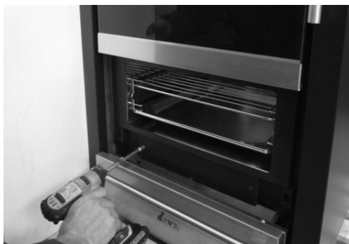
Fig. 17 - Retirer les vis
