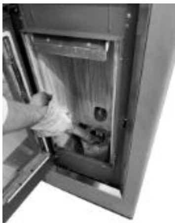
Fig. 35 - Nettoyage l'espace du brasero
