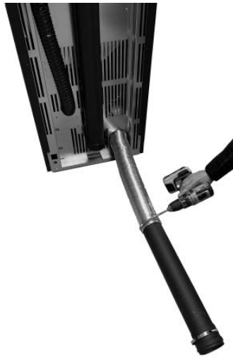
Fig. 70 - Raccorder le tuyau d.80 mm
