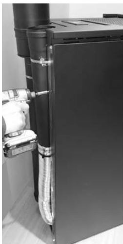
Fig. 38 - Retirer les vis postérieures
